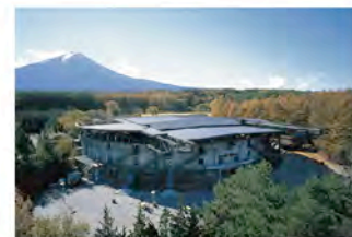
河口湖ステラシアター改修（07年6月竣工）
