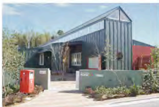
四街道さつき幼稚園（07年2月竣工）
