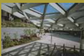
施設エントランスと地下鉄出入口を有機的につなぐサンクンガーデン。利用者の憩いの場であるとともに駅周辺の混雑緩和に寄与している
